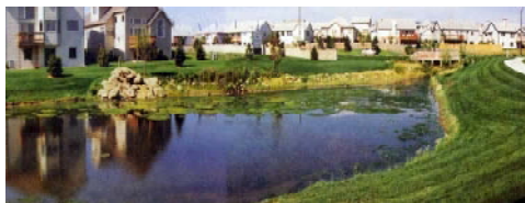
Figura 9.12 Laguna de retención aprovechando una hondonada en Fort Collins, EE.UU.
