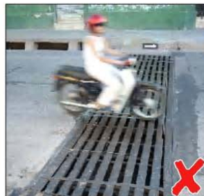
FIGURA 19 - REJA PELIGROSA POR SEPARACIÓN DE LOS BARROTES.
