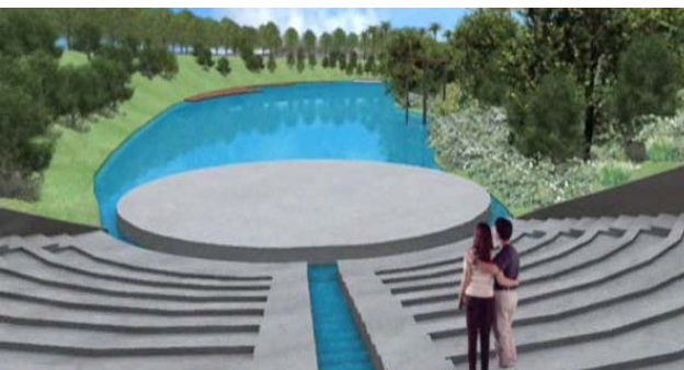
Figura 3.16. Llegada a laguna permanente (de regulación). Obra de uso mixto: como anfiteatro y disipador de energía hidráulica.
