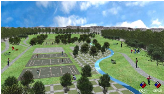
Figura 3.14 Estande de regulación. Sector con canchas deportivas. Obra de regulación de crecidas para eventos mayores.
