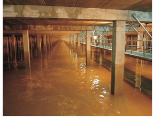
Figura 11.6. El Estanque de Tormentas de Pozuelo de Alarcón (Madrid, España) mide 150 metros de largo por 60 de ancho y más de 5 de altura. Puede recoger y filtrar hasta 30.000 toneladas de agua en caso de fuertes lluvias.
