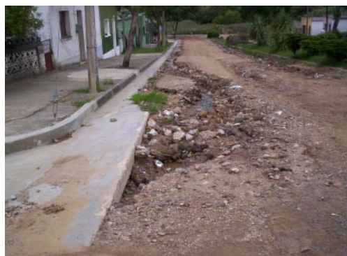
Cordón cuneta realizado sin bituminización. Puede verse la erosión de la calle.
