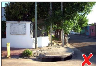
FIGURA 8 - BOCA DE TORMENTA CON DEPRESIÓN SOBRE ESQUINA CON UN TAMAÑO DE ENTRADA EXCESIVAMENTE PELIGROSO.
