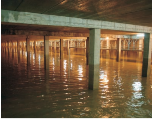
Figura 11.6. El Estanque de Tormentas de Pozuelo de Alarcón (Madrid, España) mide 150 metros de largo por 60 de ancho y más de 5 de altura. Puede recoger y filtrar hasta 30.000 toneladas de agua en caso de fuertes lluvias.
