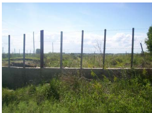
Muro construido por vecino perpendicular a flujo de cañada inmediatamente aguas abajo de asentamiento.
