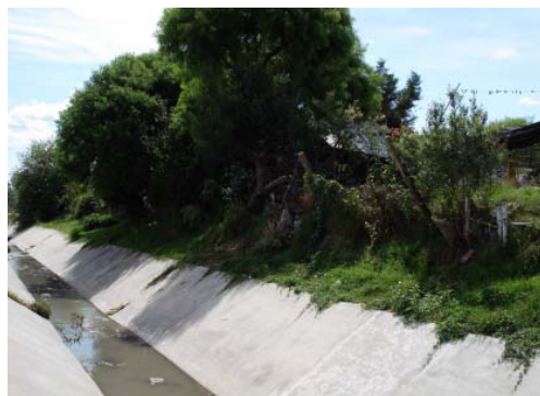
Cañada rectificada y con fondo revestido. En tiempo seco conduce aguas servidas.
