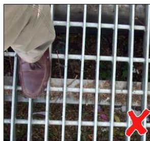
FIGURA 17 - REJA PELIGROSA POR SEPARACIÓN DE LOS BARROTES.
