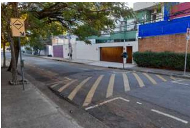
↑ San Pablo, Brasil. Los reductores de velocidad en asfalto deben seguir estándares adecuados de geometría, señalización horizontal y vertical para cumplir su función, pero sin causar problemas derivados de implementación. Imagen: German Freiberg.
