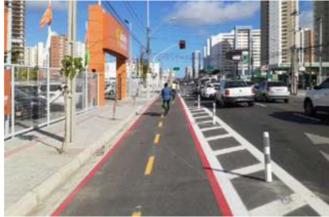
↑ Fortaleza, Brasil. Ciclovía bidireccional designada en la Av. Santos Dumont, con protección del flujo vehicular hecha de elementos separadores verticales y señalización horizontal. Imagen: Suzana Nogueira.
