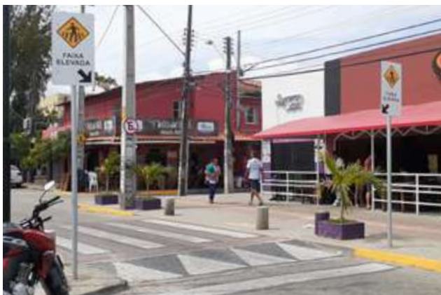
← Fortaleza, Brasil. Cidade 2000: cebra al nivel de la vereda. La elevación de la cebrá facilita la travesía del peatón e impone al conductor la reducción de su velocidad. El elemento suele ser utilizado en áreas escolares, comerciales, con gran flujo peatonal y en donde se desea reducir la velocidad. Imagen: Suzana Nogueira.
