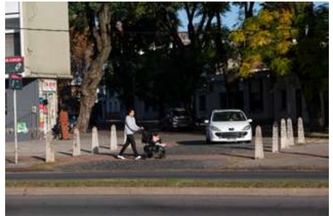
↑ Montevideo, Uruguay. Boulevard Artigas, Prado: cruce elevado en intersección entre vialidad primaria y secundaria para mayor seguridad peatonal. Imagen: Diego Battiste.
