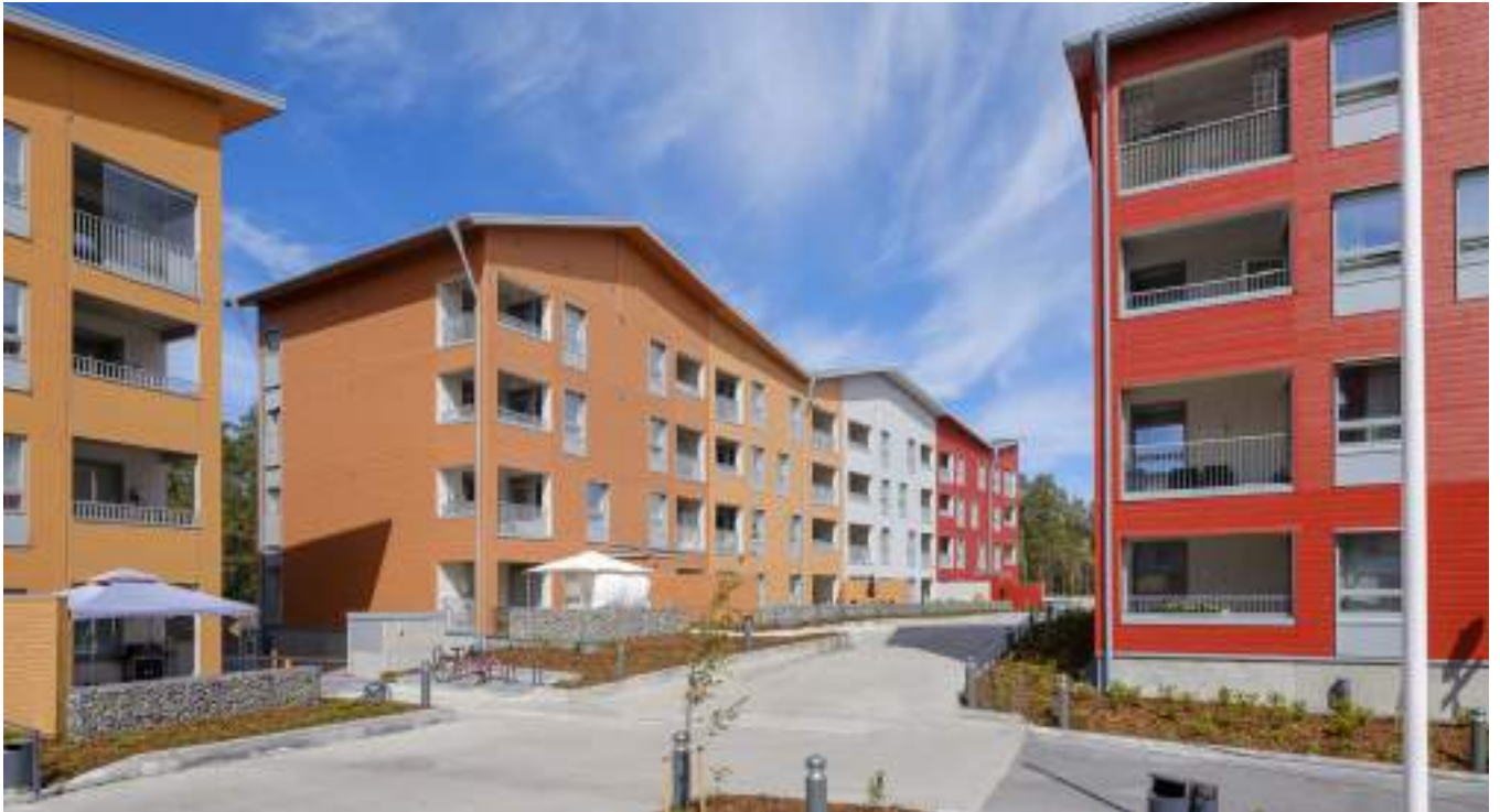
Figura 51. Edificio de vivienda en Kuninkaantammi. Fuente: https://puinfo.fi
