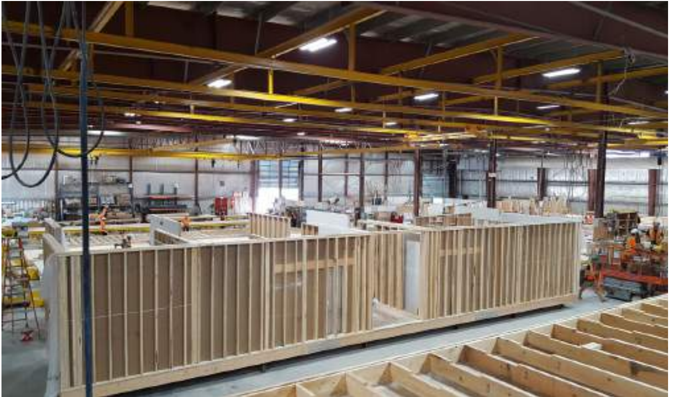
Figura 43. Planta prefabricadora de estructuras de madera Metric Modular. Fuente: www.naturallywood.com
