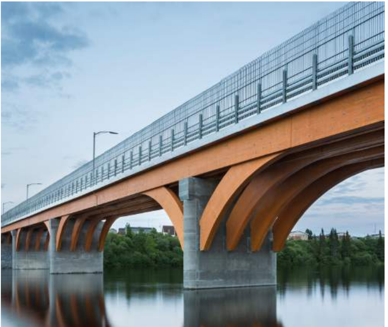
Figura 41. Mistissini Bridge, Québec, Canadá. Fuente: www.nordic.ca
