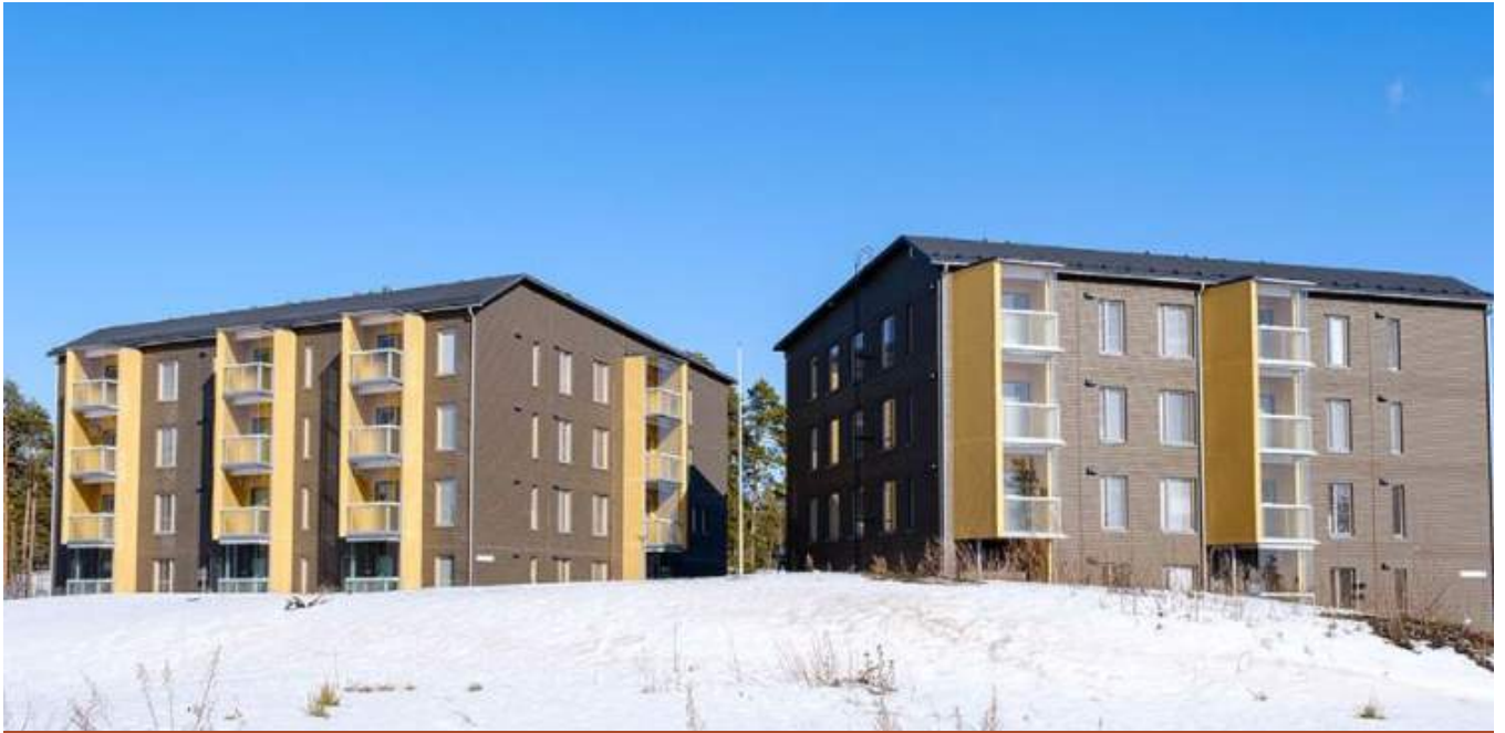
Figura 53. Vivienda en Sipoo. Fuente: https://www.a-kruunu.fi
