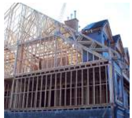
Figura 37. Construcción marco-plataforma. Fuente: www.ultratec.qc.ca
