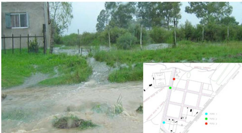
Figura 6.5: Varela: ingreso de pluviales desde predios hacia cunetas (Av. Ferrés).
