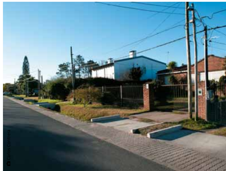
Calle con evacuación de pluviales y saneamiento en el balneario Solymar, departamento de Canelones
