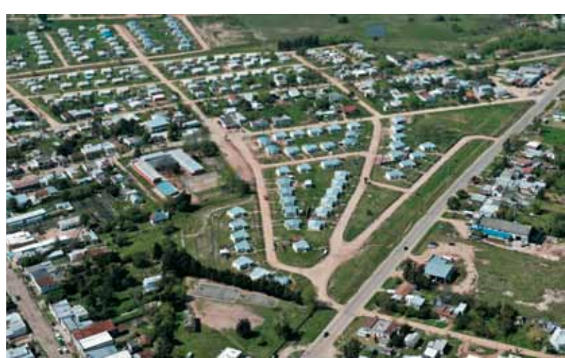
Conjuntos habitacionales de MEVIR en la ciudad de Los Cerrillos del Departamento de Canelones
