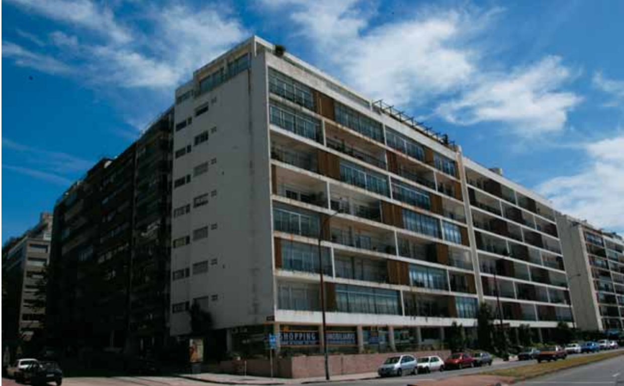
Figura 14. Emprendimiento en Propiedad Horizontal. Arq. R. Sichero. Barrio Pocitos
