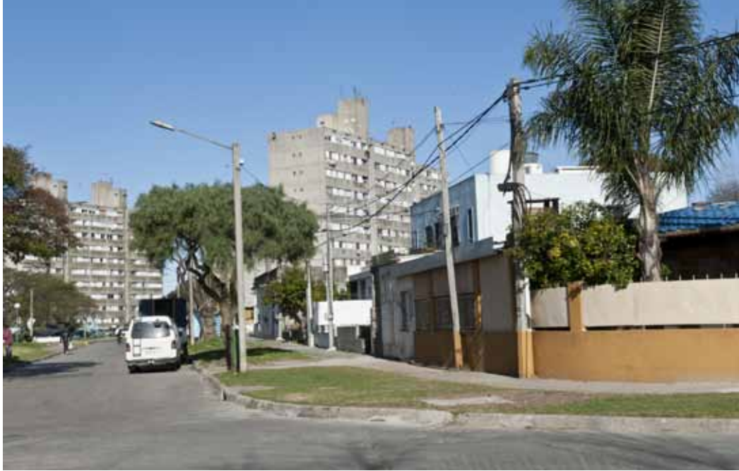
Figura 21. Conjunto habitacional Euskal Erría. Licitación Internacional BHU-BID. Barrio Malvín Norte
