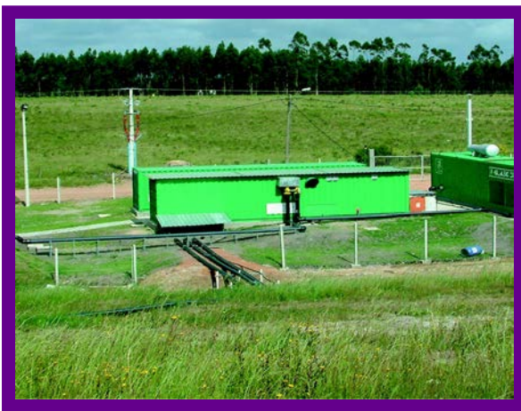
Planta de biogas, Maldonado - Foto: UCC - DINAMA
